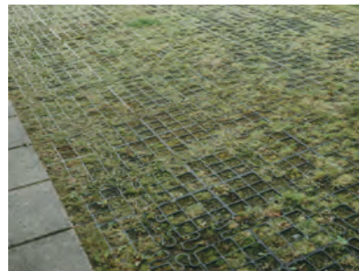
Armerat gräs släpper igenom dagvatten och kan t.ex. användas på parkeringsplatser
